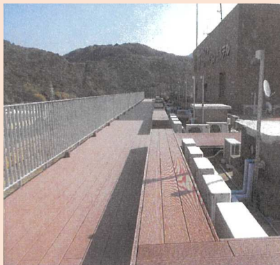
屋上展望デッキ （萩ロイヤルインテリジェントホテル）
