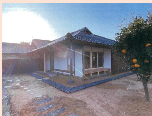
古民家改修による宿泊施設（柳井邸）
